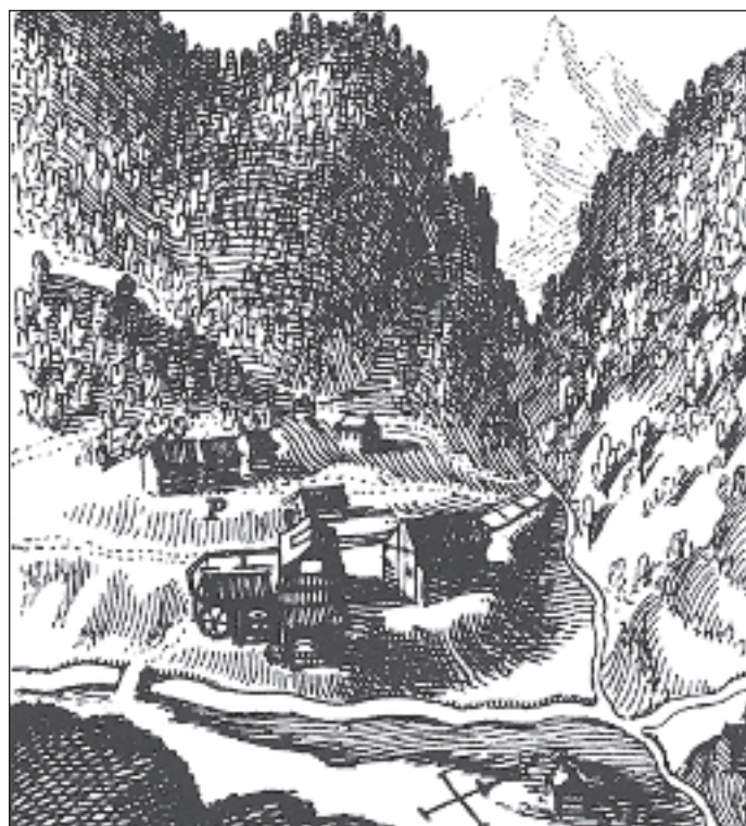
Das Eisenbergwerk im Grund nach einem Kupferstich von Matthäus Merian 1653. Die bescheidene Anlage war mehrheitlich aus Holz gebaut. Das Wasserrad vor der Hütte unten links könnte den Blasebalg des Schmiedeofens angetrieben haben.
